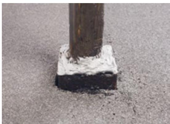
Вместо полиуретанового герметика можно также использовать Мастику кровельную горячую ТЕХНОНИКОЛЬ № 41 («Эврика») — следует залить горячую мастику в стакан до края и сверху нанести сланцевую посыпку.
