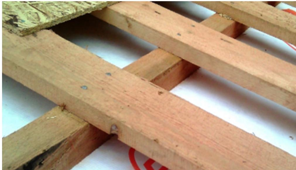
Перед установкой обрешетки укладывают карнизный настил и обшивают фронтонные свесы строгаными досками. Обрешетка непосредственно воспринимает нагрузку кровельного материала и, в свою очередь, давит через контробрусья на стропила, которые передают тяжесть крыши несущим стенам. Обрешетку крепят к деревянным стропилам саморезами или гвоздями.
