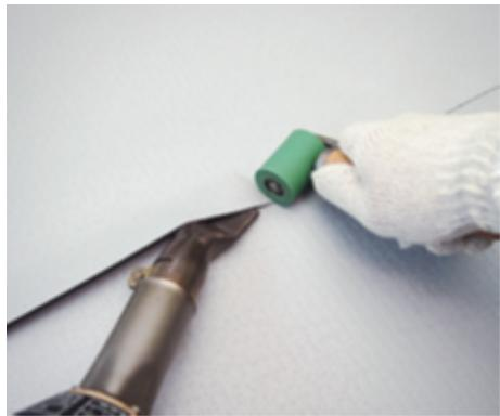
Для выполнения окончательной сварки вставьте горячий фен в воздушный карман под углом примерно **45°**. При этом кончик сопла должен на **1-2 мм** высовываться из нахлеста.
