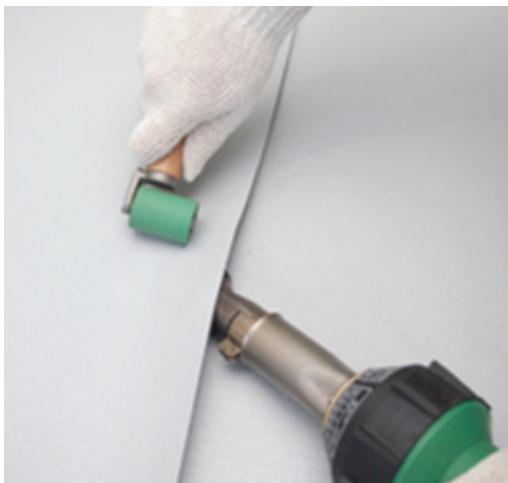
Для предотвращения утечки горячего воздуха из зоны сварки сформируйте «воздушный карман» – быстро ведите фен вдоль шва, прикатывая мембрану одним ребром прикаточного валика, упирая его в кромку сопла.
