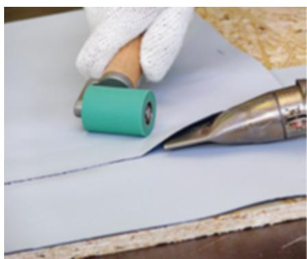
Чтобы избежать подплавления нижней мембранны, приподнимите кончик сопла на **1-2 мм**.
