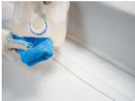
Для удаления грязи с поверхности мембранны в зоне сварного шва или активации старой мембранны при выполнении локального ремонта обработайте поверхность ПВХ мембранны при помощи Очистителя ТЕХНОНИКОЛЬ и хлопковой ткани.
