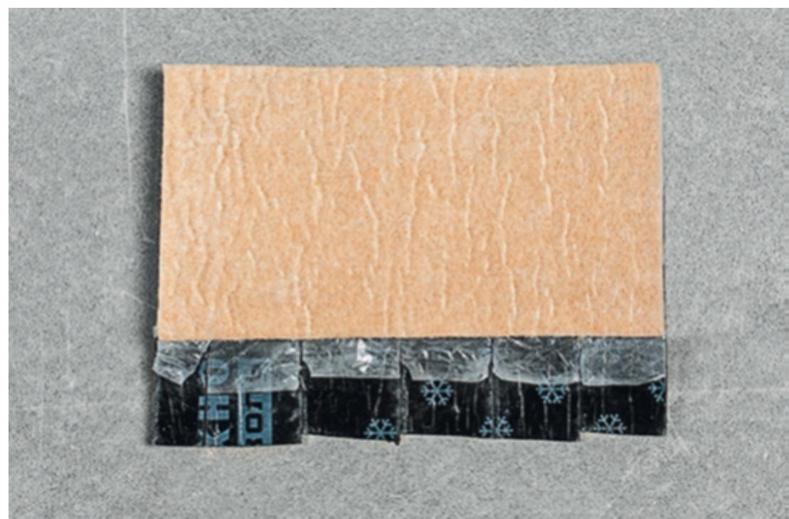
Обверните заплатку вокруг металлической гильзы и проклейте шов лентой-герметиком.
