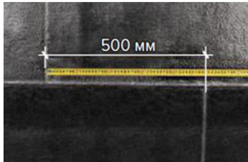
Полотна смежных рулонов наплавляйте с торцевым нахлестом не менее 150 мм.
