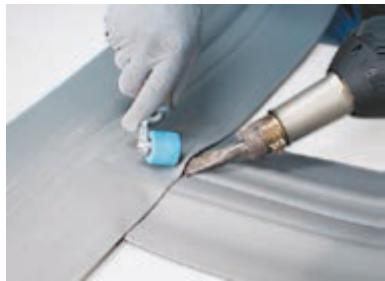
Т-образный элемент готов. Проверьте качество сварного соединения.
