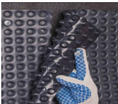
Верхнюю часть края мембраны необходимо закрепить выше уровня гидроизоляции на 300 мм.
