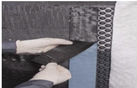
Скрепите геотекстиль для формирования целостности фильтрующего слоя. Используйте двух- или одностороннюю клейкую ленту для соединения геотекстиля. Если клейкая лента односторонняя, ее ширина должна быть не менее 50 мм.
