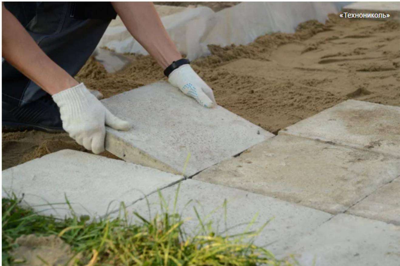
Зимой обводненный грунт то подмерзает, то оттаивает, причем неравномерно, поднимая и опуская плитку. Результат: дорожка идет волнами, на ней появляются лужи, пыль превращается в грязь, а песок — в плодородный (разумеется, для сорной растительности) грунт.
