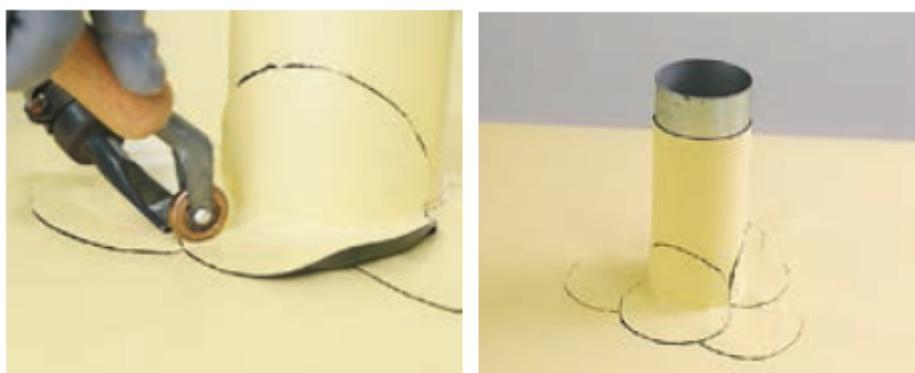
После того как все заготовки надежно приварены к «лепесткам» и основной мемbrane, приступайте к окончательной герметизации выполненного элемента.
