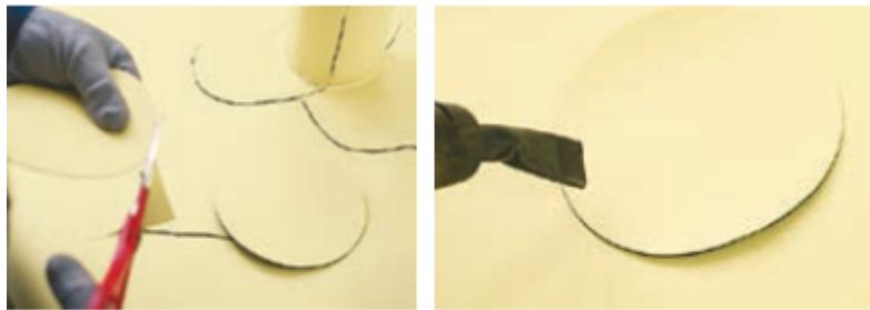
Приварите приготовленные заготовки, используя латунный прикаточный ролик, начиная от основания трубы и двигаясь к краям.
