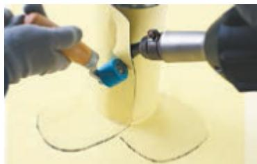
После того как «лепестки» приварены к основной мемbrane, сварите образовавшийся нахлест на трубе.
