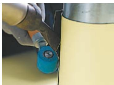
После того как нахлест на трубе и все «лепестки» приварены, подготовьте заплатки размером не менее 50 мм в диаметре в количестве, равном количеству резов заготовки.
