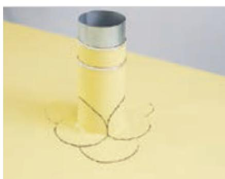
Заполните образовавшуюся пазуху герметиком по всему контуру трубы до образования видимого вздутия.
