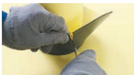
**ВАЖНО! Обязательно скруглите острые углы, образовавшиеся в результате реза заготовки.**
