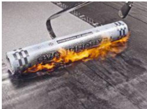
В случаях наплавления по крупнозернистой посыпке (торцевые, боковые нахлести и т. п.) удалите посыпку из области наплавления:
