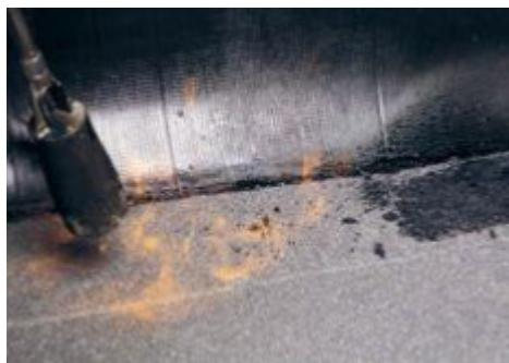
Для обеспечения нахлеста с дополнительным верхним слоем, разогрейте материал и втопите посыпку.
