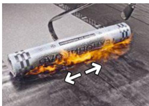
При наплавлении смежных рулонаов траектория движения горелки должна описывать букву «Г», с дополнительным прогревом той области материала, которая идет внахлест.
