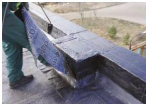
После выполнения вертикальной приклейки, наплавьте материал на переходной бортик и на горизонтальный участок.
