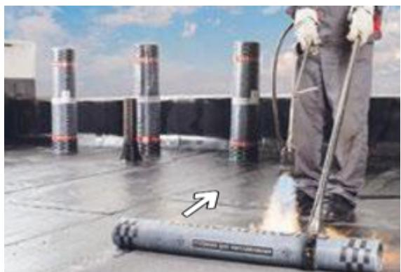
**Способ № 2 применяют при больших уклонах кровли (более 8%), чтобы не допускать возможного смещения рулона при наплавлении**
