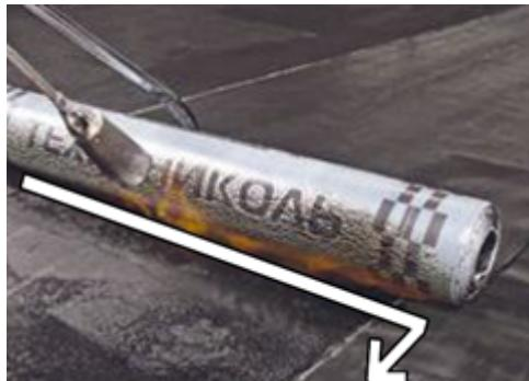
Деформация рисунка свидетельствует о правильном разогреве битумно-полимерного вяжущего с нижней стороны рулонного материала.
