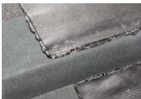
Аналогичным образом выполните наплавление первого слоя вертикальной гидроизоляционной мембраны.
