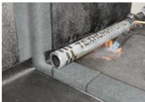
Вытек битума из-под боковой кромки свидетельствует о качественном наплавлении материала.
