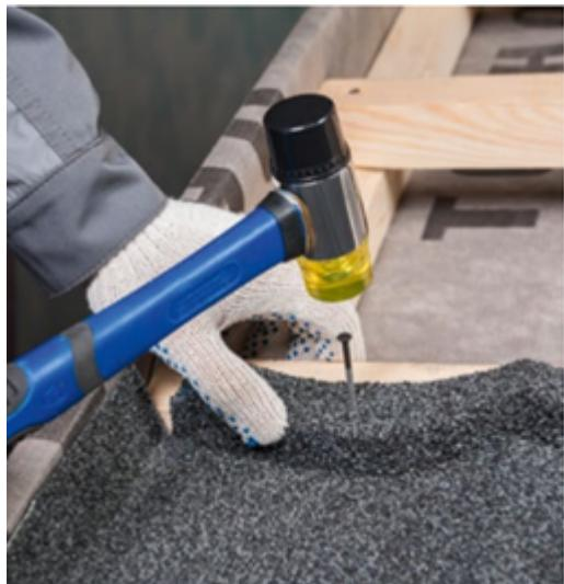
Гвозди и саморезы в основание панели установить под углом 60 градусов к плоскости ската и в том месте, где волна касается деревянной шаговой обрешетки.
