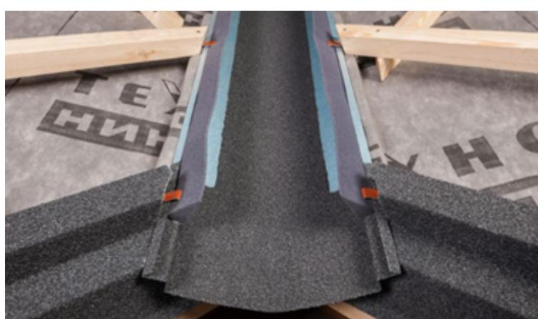
Первый элемент ендовы заведите на нижнюю полку капельника. Выходящую за пределы капельника часть элемента ендовы подрежьте и загните вниз. Каждый вышележащий элемент ендовы заведите в нижележащий и зафиксируйте при помощи кляммеров. Все нахлести на величину 15-20 см организовывайте по принципу каскадности воды. На бортах (слева и справа) лотков ендовы наклейте специальный поролоновый уплотнитель.
