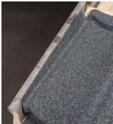
Рулонный аэроэлемент конька уложите самоклеящимися полосами вниз. После монтажа конькового элемента удалите защитную пленку и аэроэлемент прикатайте резиновым валиком к панелям ТЕХНОНИКОЛЬ LUXARD до полного склеивания с ними.
