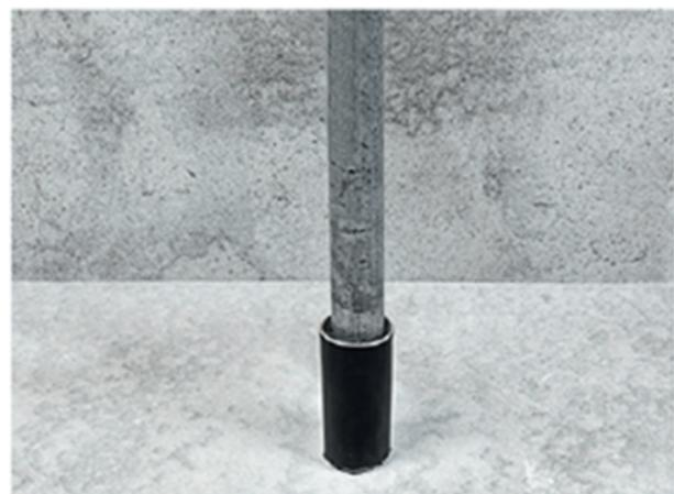
При использовании различных типов пластмассовых труб рекомендуется использовать специальные противопожарные муфты, препятствующие распространению огня через строительные конструкции (перекрытия, стены).
