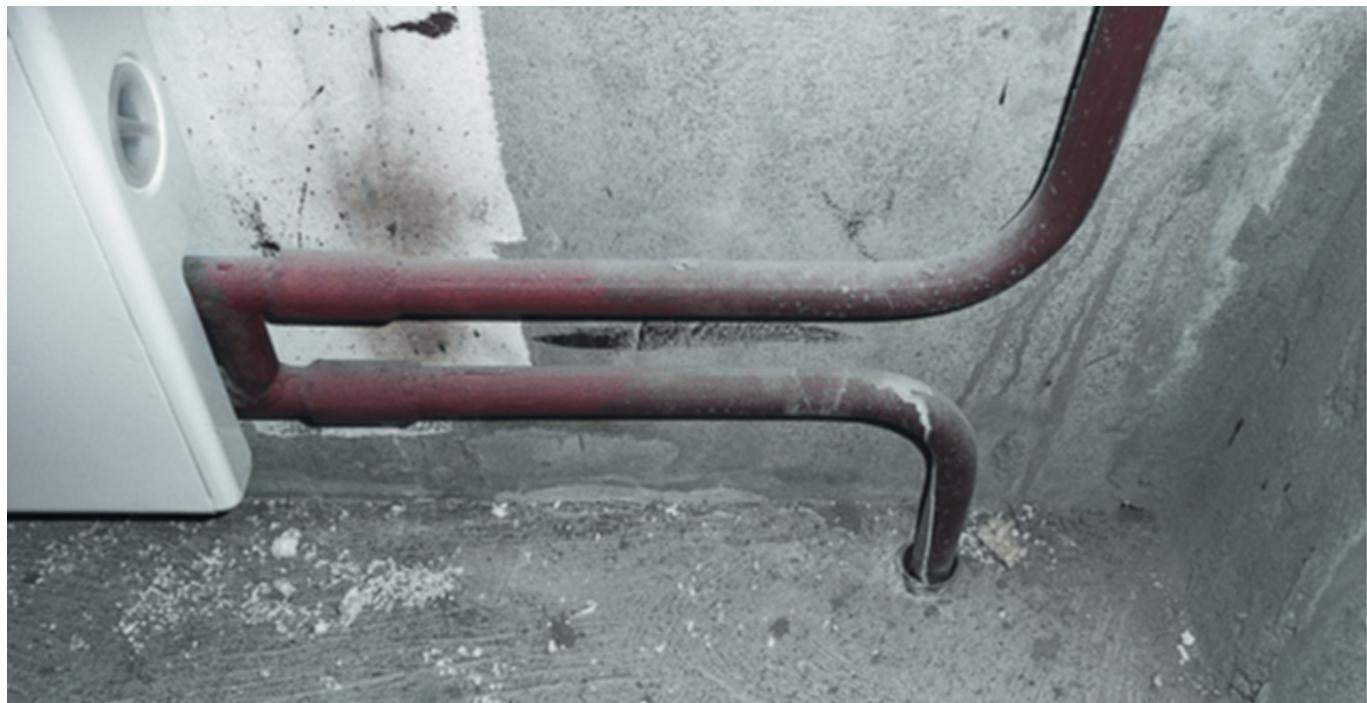
Гильза должна полностью изолировать трубу от междуэтажного перекрытия и напольного покрытия.
