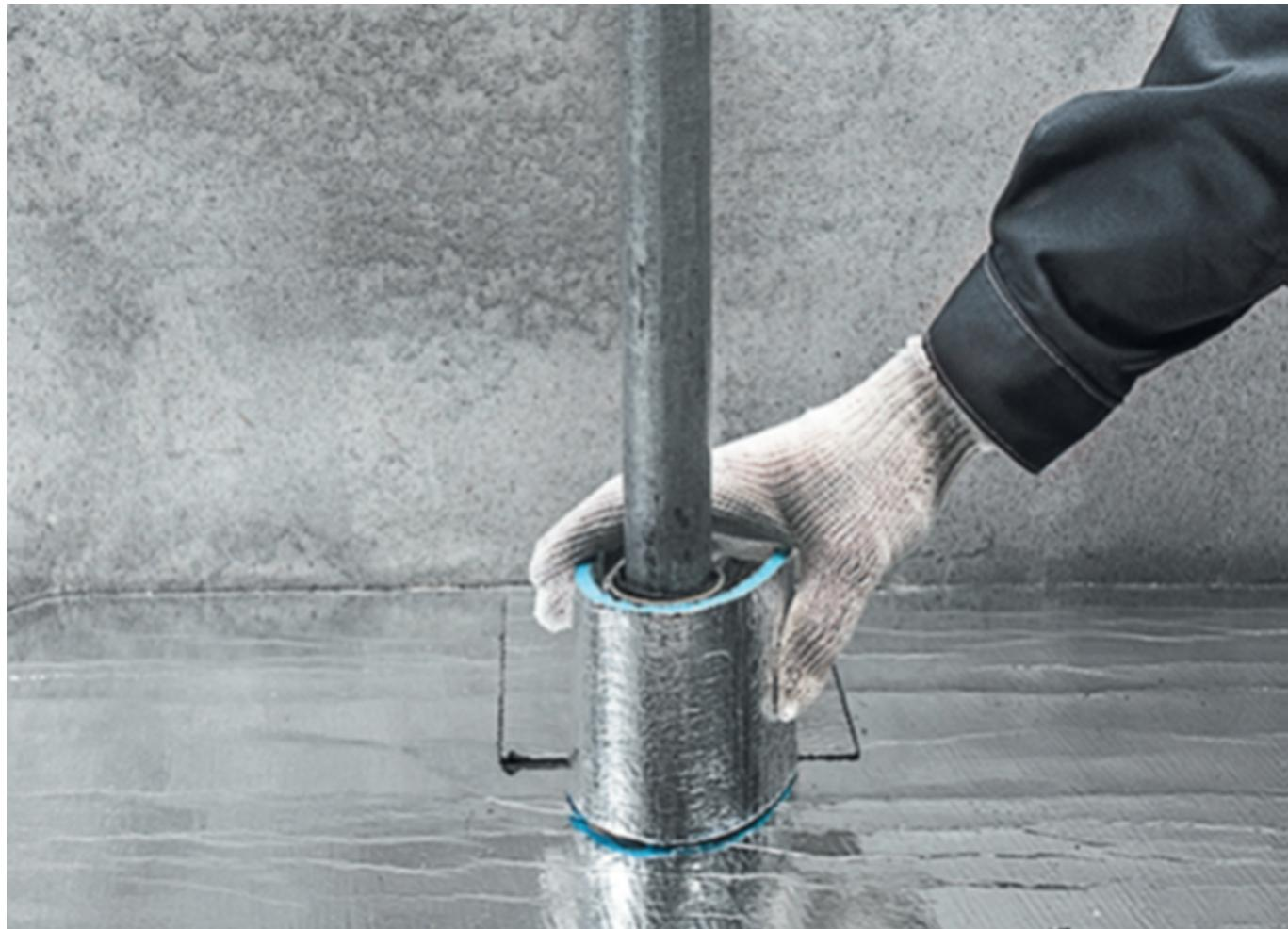
Обверните металлическую гильзу самоклеящейся демпферной лентой.
