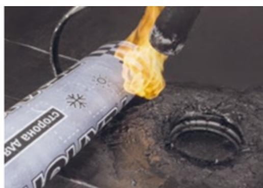
Чтобы не повредить вертикальную трубу воронки пламенем горелки временно заткните трубу негорючим материалом. Прорежьте кровельный ковер по отверстию трубы водоприемной воронки.
