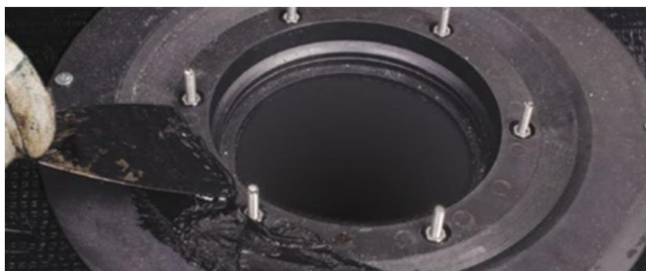
Произведите укладку нижнего слоя. Боковой нахлест полотен должен проходить через ось воронки.
