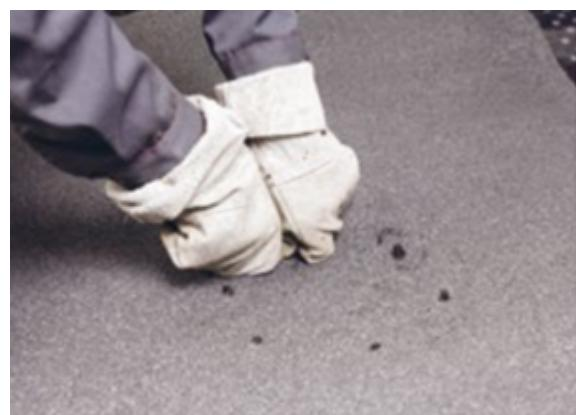
Прорежьте кровельный ковер по диаметру трубы водоприемной воронки.
