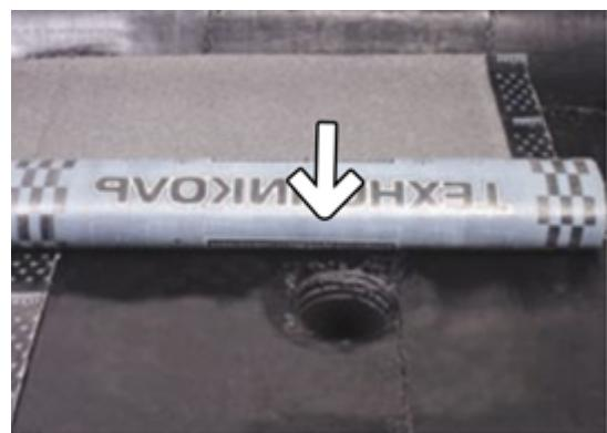
Пока не остыл материал, продавите болтовые соединения воронки через материал Техноэласт ЭКП.
