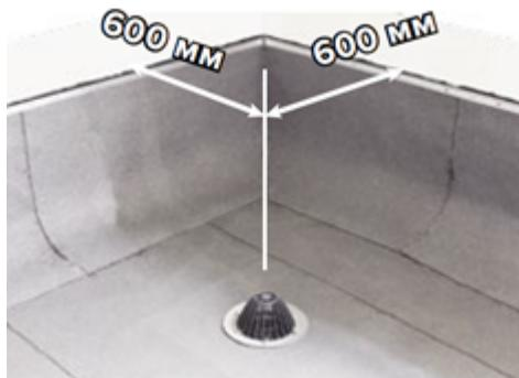
Создайте дополнительный контруклон от вертикальных конструкций (стены, парапеты и т. п.) к водоприемной воронке.
