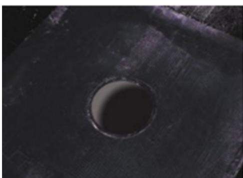
Разогрейте пламенем горелки область слоя усиления, на которую будет установлена воронка. Вдавите чашу водоприемной воронки в разогретую область. Следите за равномерным вытеком битумно-полимерного вяжущего из-под фланца воронки. Вытек обеспечивает полную герметичность соединения.
