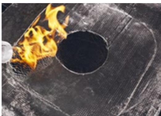
Закрепите водоприемную воронку к основанию, используя минимум 4 крепежных элемента. Крепление предотвратит возможные смещения воронки при последующем монтаже кровли. В качестве крепежных элементов применяйте остроконечные саморезы ТЕХНОНИКОЛЬ EDS-S 4,8 мм с полиамидной гильзой.
