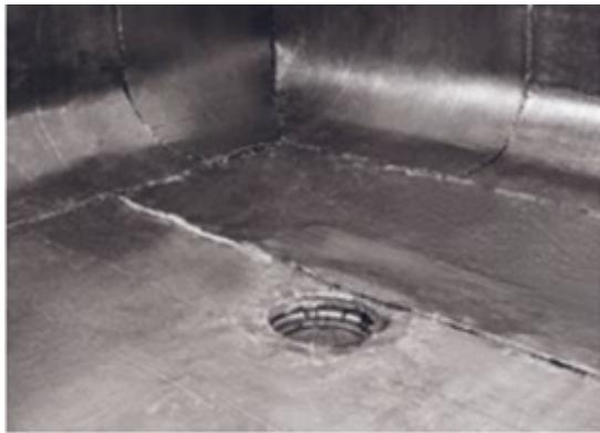
Наплавьте верхний слой из материала Техноэласт ЭКП
