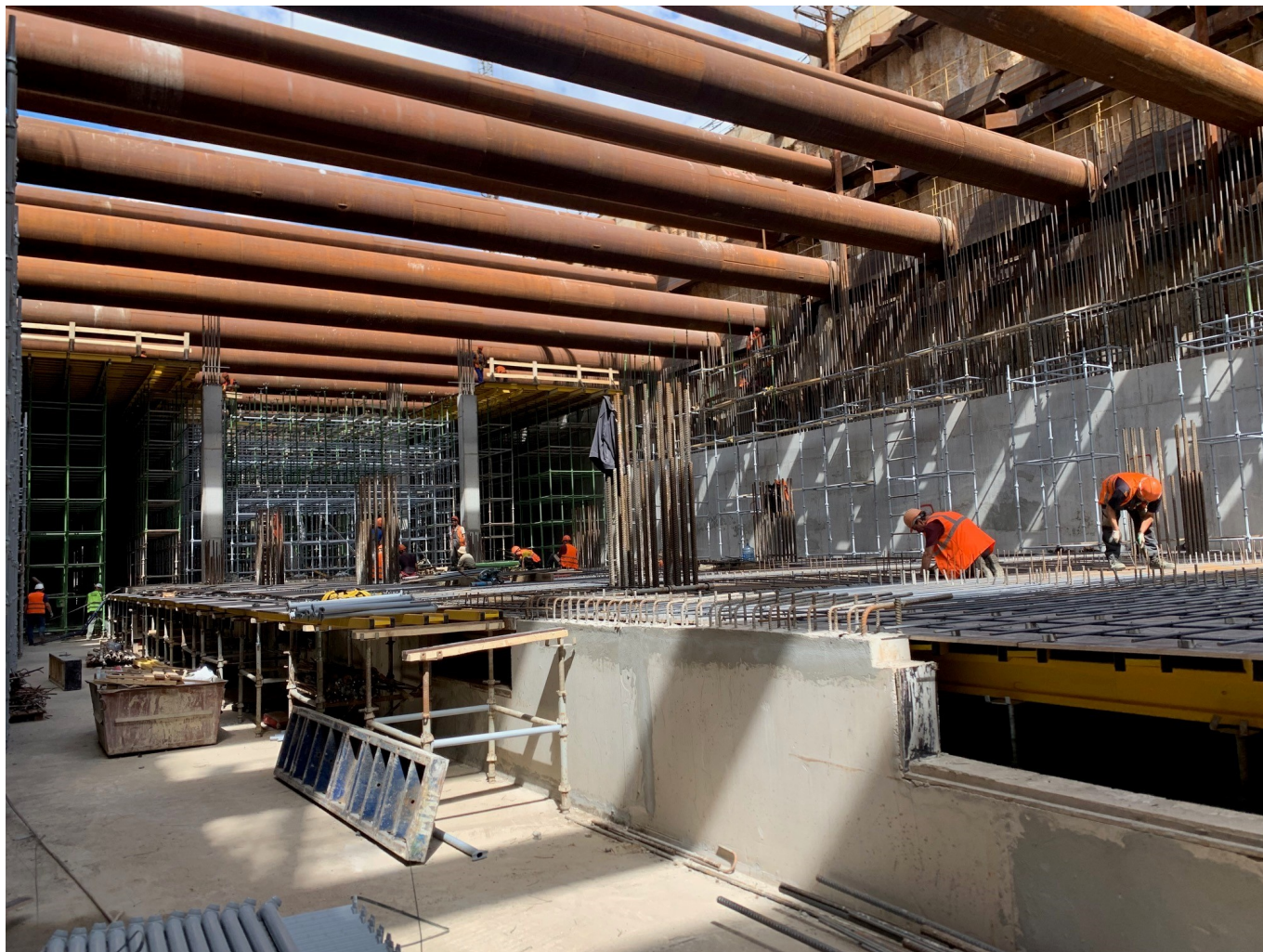
Строительство открытым способом станционного комплекса «Академическая» Троицкой линии метро Москвы
