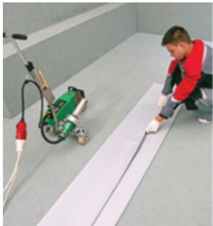
В начале рабочей смены или в случае резкого изменения погодных условий нужно сделать пробную сварку для подбора или уточнения параметров сварки. При необходимости применять очиститель для ПВХ. Для этого возьмите **2** полосы мембранны достаточной ширины и длины.
