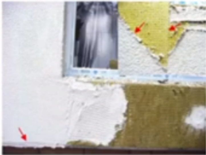
Армирование декоративной штукатуркой
