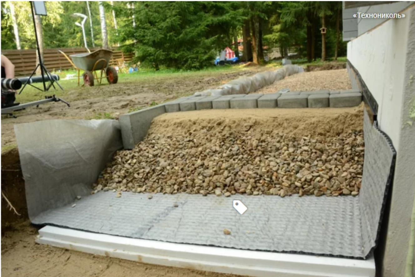
На фото: «пирог» отмостки в разрезе. Поверх уплотненного основания — утеплитель XPS. На нем — профилированная мембрана PLANTER Geo с геотекстилем (два в одном). Поверх них — щебень с песком.
