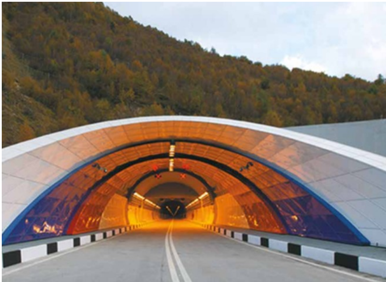
Рокский автодорожный тоннель, республика Северная Осетия-Алания. Возводился горным способом с применением буровзрывных работ. Гидроизоляция с помощью ПВХ-мембраны LOGICBASE V-SL 1,5 мм
