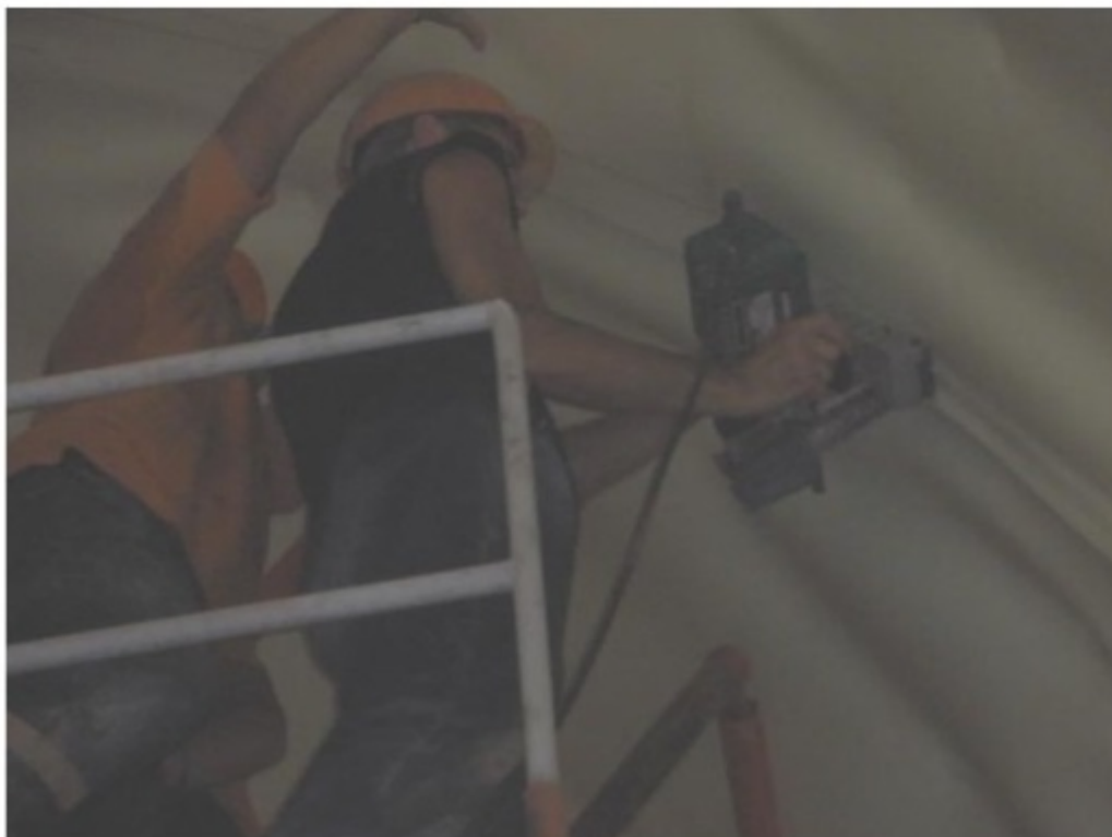
Сварка полотен мембраны LOGICBASE V-SL в сводчатой части тоннеля.
