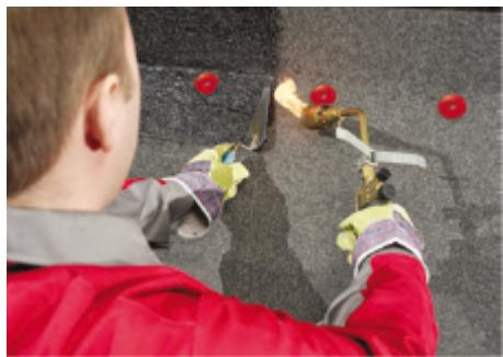
Дополнительный слой должен заходить на вертикальную поверхность парапета на высоту не менее 250 мм и на горизонтальную поверхность основания на 150 мм от наклонного бортика.
