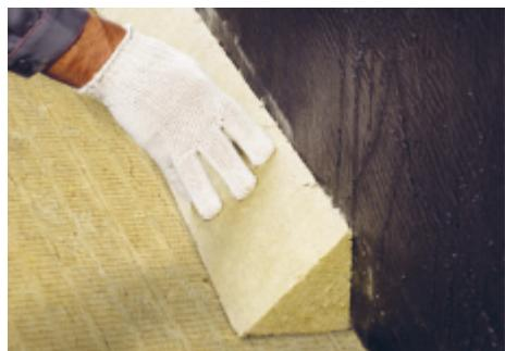
Подведите рулон Техноэласт СОЛО РП1 к вертикальной конструкции и заведите материал на наклонную плоскость бортика.
