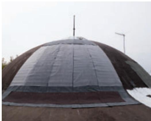
Разрезать гонт гибкой черепицы на 3 части - на выкройки по 330 мм.
