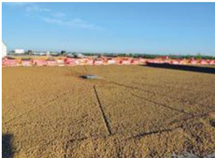
По уклонообразующему слою укладывается армирующая сетка из проволоки Вр3 размером ячейки 150×150 мм и выполняется стяжка из цементно-песчаного раствора.
