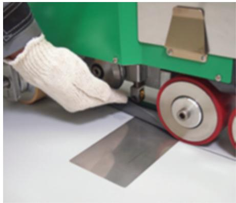
Перед началом сварки потяните за край верхней мембранны, чтобы облегчить введение сопла автомата в зону нахлеста. Соблюдайте осторожность, чтобы не задеть горячие части автомата.
