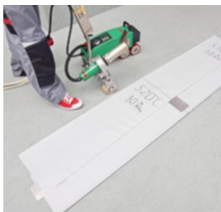
Сварите полосы мембранны, изменяя скорость сварочного аппарата на участках длиной не менее **50 см**. Для удобства работы полосы можно предварительно разметить маркером.
