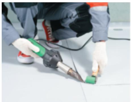
Проверьте качество сварного шва пробником или плоской шлицевой отверткой. Места ручной сварки обработайте жидким ПВХ ТЕХНОНИКОЛЬ.
