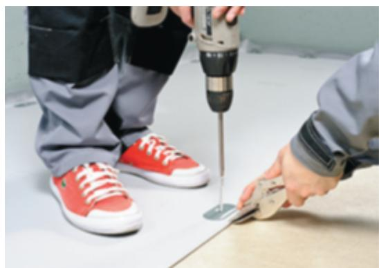
Крепление осуществляйте в маркерную линию, нанесенную вдоль каждого рулона мембранны **LOGICROOF** и **ECOPLAST**.
