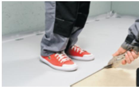
В зимнее время, во время укладки мембранны при отрицательных температурах, возможно появление небольших волн на поверхности полотна. Эти волны могут быть обусловлены особенностями материала (разность температурных усадок между полимером и армирующей сеткой) и, как правило, исчезают после релаксации мембранны во время летнего сезона.
