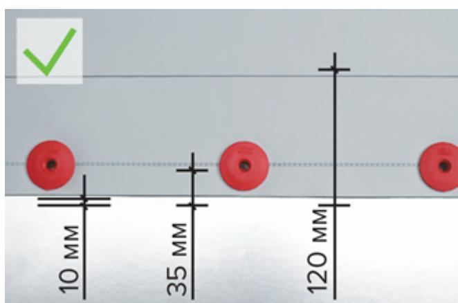
Крепеж установлен не по маркерной линии.
