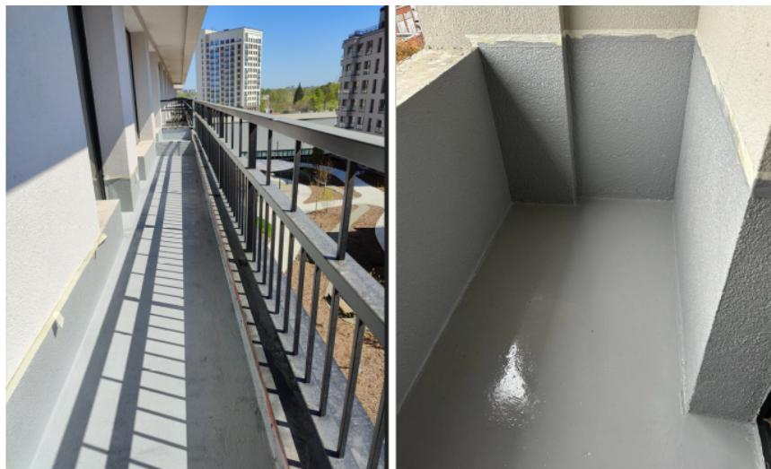
Перед нанесением всех гидроизоляционных материалов необходимо тщательно подготовить поверхность. Она должна быть чистой, сухой, прочной.
