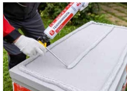
Нанесение клей-пены для XPS
