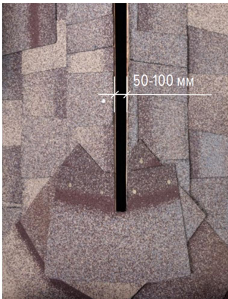
Фиксация аэроэлемента производится кровельными гвоздями или саморезами в местах,
