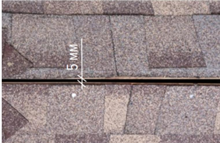
Укладываем коньково-карнизную черепицу снизу-вверх после отбивки габаритов будущего ребра (две полосы вдоль ребра) с помощью шнурки (отбивки). Фиксируем каждую черепицу двумя или четырьмя гвоздями (по два с каждой стороны).
