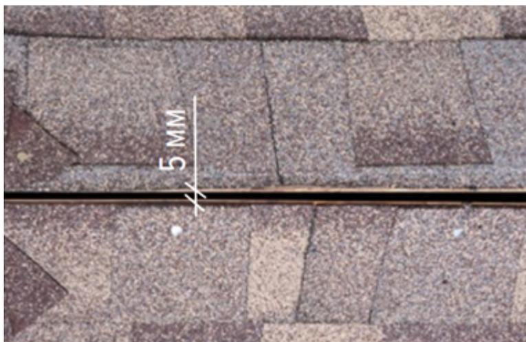
Укладываем коньково-карнизную черепицу снизу-вверх после отбивки габаритов будущего ребра (две полосы вдоль ребра) с помощью шнуры (отбивки). Фиксируем каждую черепицу двумя или четырьмя гвоздями (по два с каждой стороны).
