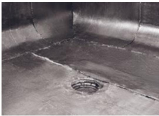
Наплавьте верхний слой из материала Техноэласт ЭКП
