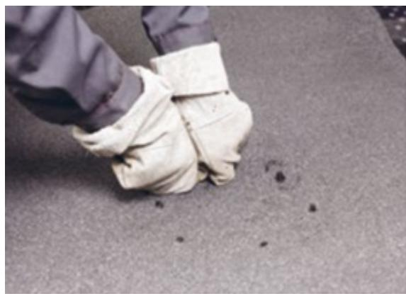
Прорежьте кровельный ковер по диаметру трубы водоприемной воронки.
