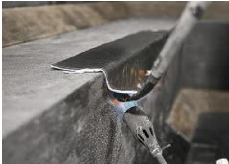
Затем в верхней части на горизонтальной поверхности.
