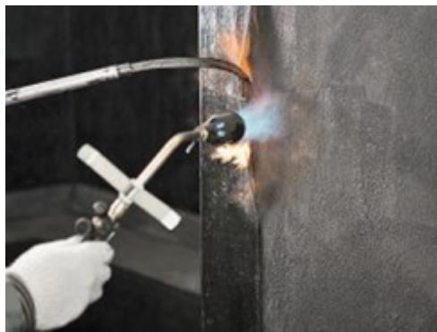
Во избежание образования морщин и волн прикатайте наплавленный материал силиконовым роликом.
