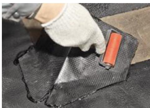
Элемент усиления должен быть качественно наплавлен. Одним из признаков качественного наплавления является вытекание битумной массы из-под боковой кромки материала сплошным валиком примерно на 5÷25 мм.
