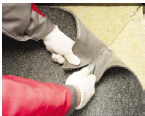
В области заведения материала на переходной бортик вдоль всей вертикальной конструкции выполните механическое крепление с шагом не более 250 мм.
