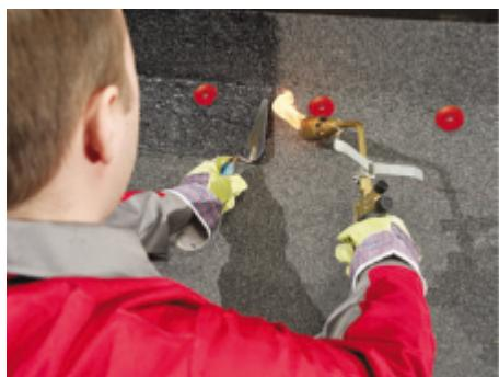
Наплавьте заплатки из материала Техноэласт ЭПП на угол по всей высоте и горизонтальной плоскости парапета для герметизации шва.
