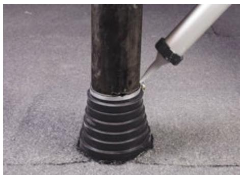
Установите обжимной хомут на уплотнитель и плотно затяните.
