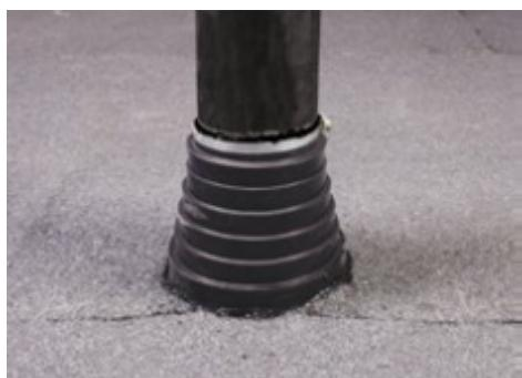
Обжимной хомут из оцинкованной стали обеспечит плотное соединения фитинга с трубой.
