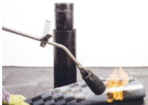
Наплавьте верхний слой из материала Техноэласт ЭКП.
