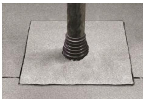
Для герметизации соединения между трубой и уплотнителем нанесите герметизирующую мастику ТЕХНОНИКОЛЬ № 71.
