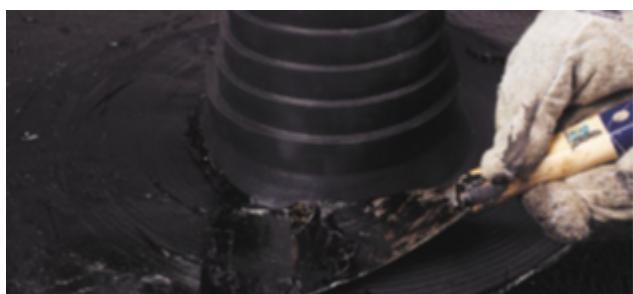
Наплавьте верхний слой из материала Техноэласт ЭКП.
