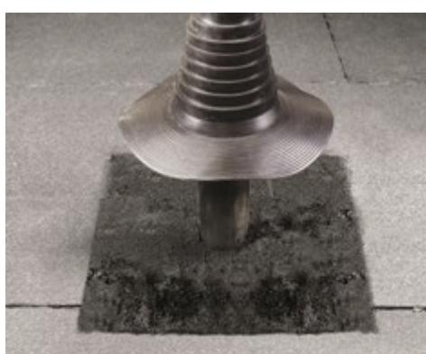
Следите за равномерным вытеком битумно-полимерного вяжущего из-под юбки уплотнителя. Вытек обеспечивает полную герметичность соединения.
