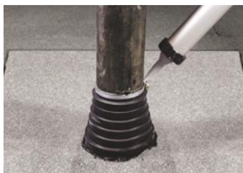
Установите обжимной хомут на уплотнитель и плотно затяните.
