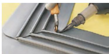
Приварите плоские края гидрошпонок друг к другу, используя латунный ролик.
