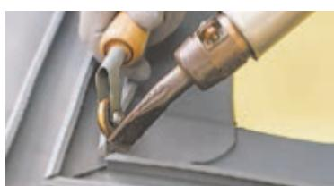
Приварите верхнюю часть нахлеста к поверхности гидроизоляционной мембраны, используя тефлоновый ролик.
