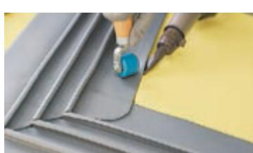
После того как плоские части гидрошпонок сварены между собой и приварены к гидроизоляционной мемbrane, выполните сварку ребер гидрошпонок.
