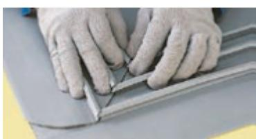
Снимите фаску по краю гидрошпонки от поставленной отметки до торца среза шпонки.
