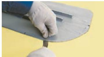
Завальцуйте край гидрошпонки на всем протяжении, где была снята фаска.
