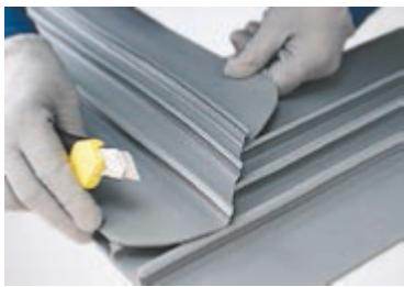
Разметьте, а затем под режьте ребра гидрошпонки под углом 45°.
