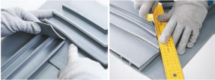
Подрежьте вначале только ребра гидрошпонки, а для резки плоской части уложите шпонку на ровную и прочную поверхность.
