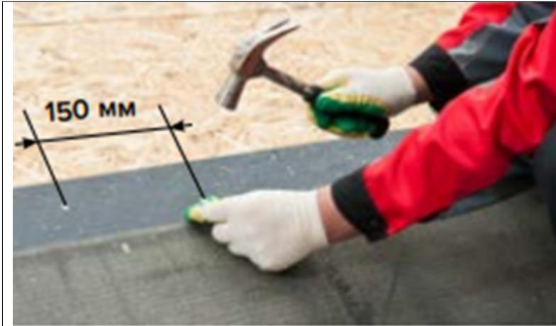
Выполнить механическую фиксацию материала деревянными кровельными гвоздями в зоне продольного перехлеста. Шаг крепления гвоздей составляет 150 мм и выполняется в разбежку
