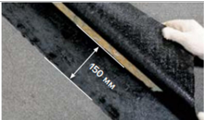
Поперечные нахлести составляют 150мм. Место поперечного перехлеста подкладочного ковра ANDEREP ULTRA промазывается тонким слоем битумной мастики ТЕХНОНИКОЛЬ №23 (Фиксер). Формирование поперечного перехлеста подкладочного ковра ANDEREP NEXT SELF не требует применения мастики
