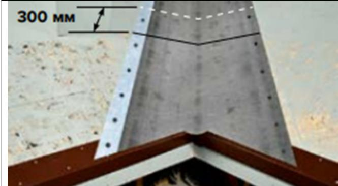
При возникновении нахлеста материала в зоне ендовой он выполняется в верхней ее части. Ширина поперечного перехлеста в зоне ендовой составляет 300мм. Поперечный перехлест подкладочного ковра ANDEREP ULTRA промазывается тонким слоем битумной мастики ТЕХНОНИКОЛЬ №23 (Фиксер).
