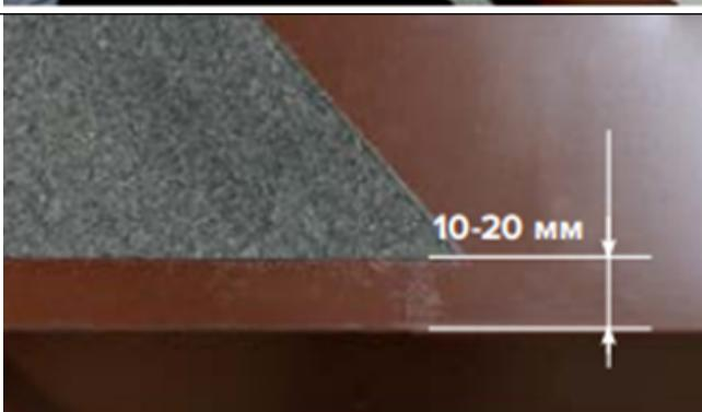
На карнизном свесе самоклеящийся подкладочный ковер подрезается и укладывается так, чтобы до перегиба карнизной планки остался зазор 10-20мм. На нижнем краю ендовой ковер необходимо подрезать с небольшим закруглением («язычком»), для того чтобы закрыть стыки карнизных планок в ендовой и обеспечить правильный отвод воды.
