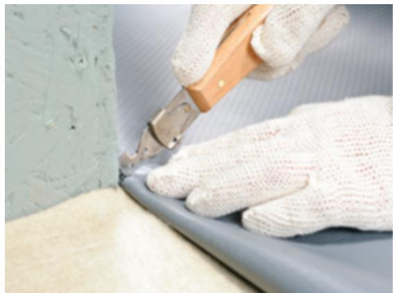
Проведите линию под углом **45°** от точки к краю полотна мембранны и разрежьте мембранны кровельным ножом по этой линии.
