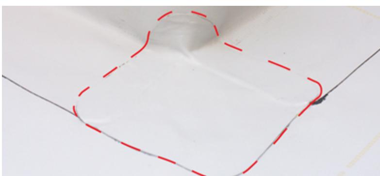
Вырежьте заготовку из неармированной мембранны V-SR таких размеров, чтобы она не менее чем на **30 мм** перекрывала нахлест вертикальной и горизонтальной мембранны.
