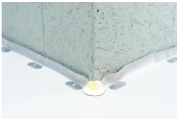
Проткните мембрану кончиком кровельного ножа в точке соприкосновения мембранны и основания угла.
