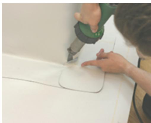
При помощи узкой насадки фена и пальцев постепенно приварите деталь.
