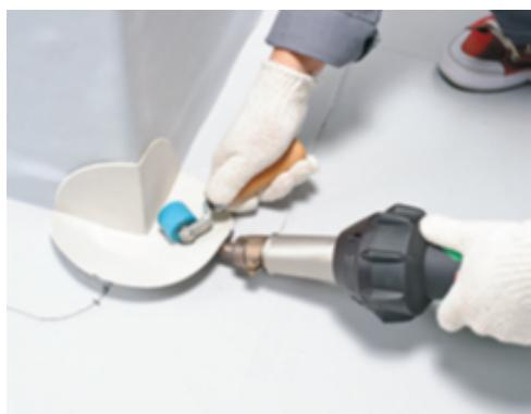
Окончательно приварите элемент по внешнему краю. Аналогично приварите элемент на вертикальной части. Проверьте качество выполненных швов пробником. Обработайте швы жидким ПВХ ТЕХНОНИКОЛЬ.
