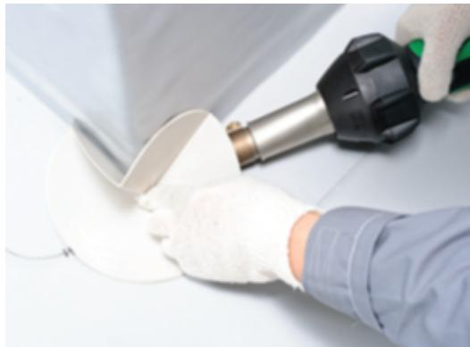
Начинайте приварку элемента вдоль углов от центра к краям накладки. Используйте узкое сопло фена **20 мм** и латунный прикаточный ролик.
