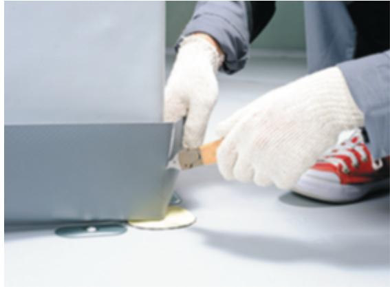
Закруглите все углы с помощью ножниц. Приварите края заготовки к основной мемbrane.
