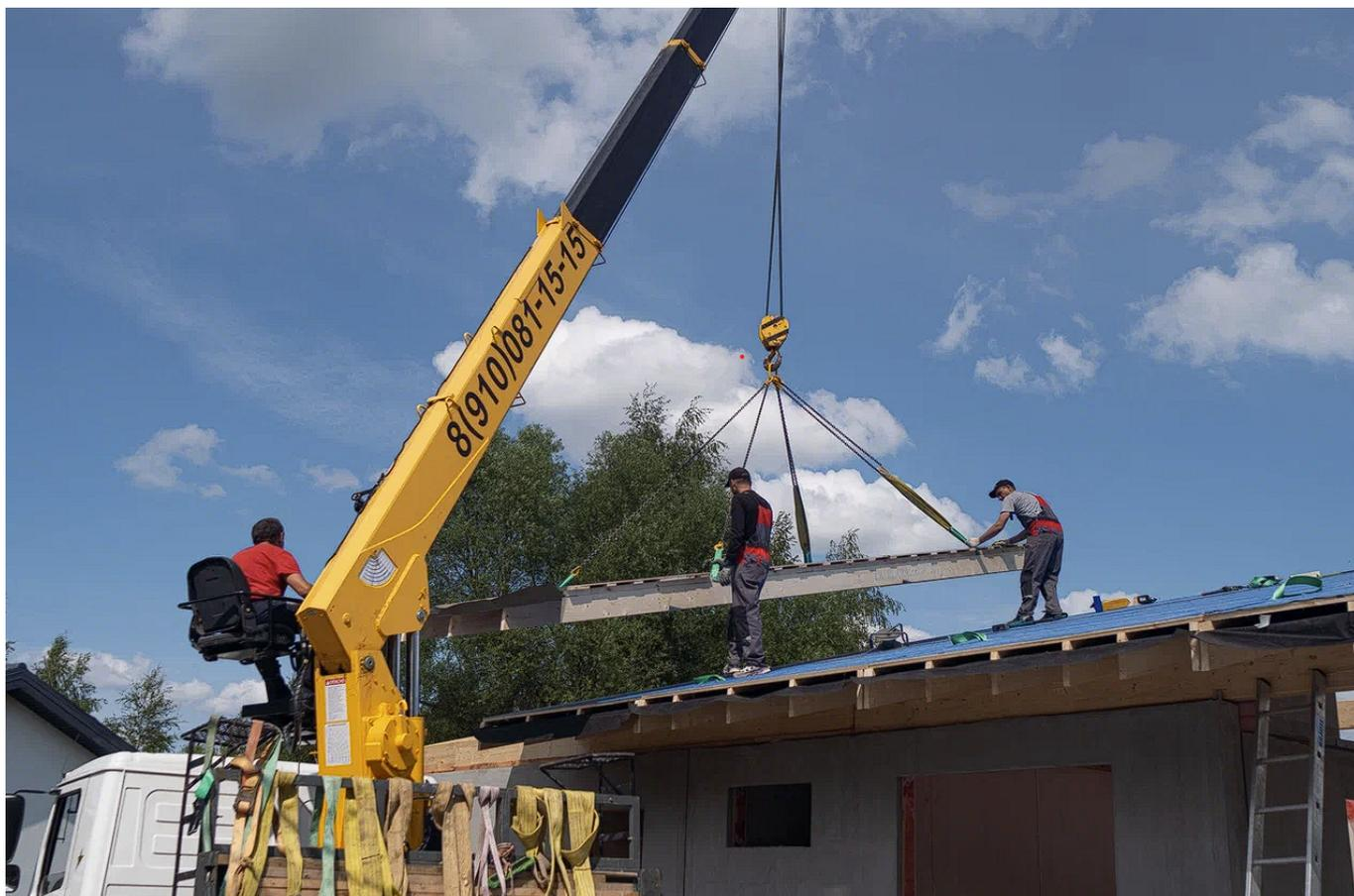
*Рис.3. Монтаж кровельной панели при помощи специализированной техники*
