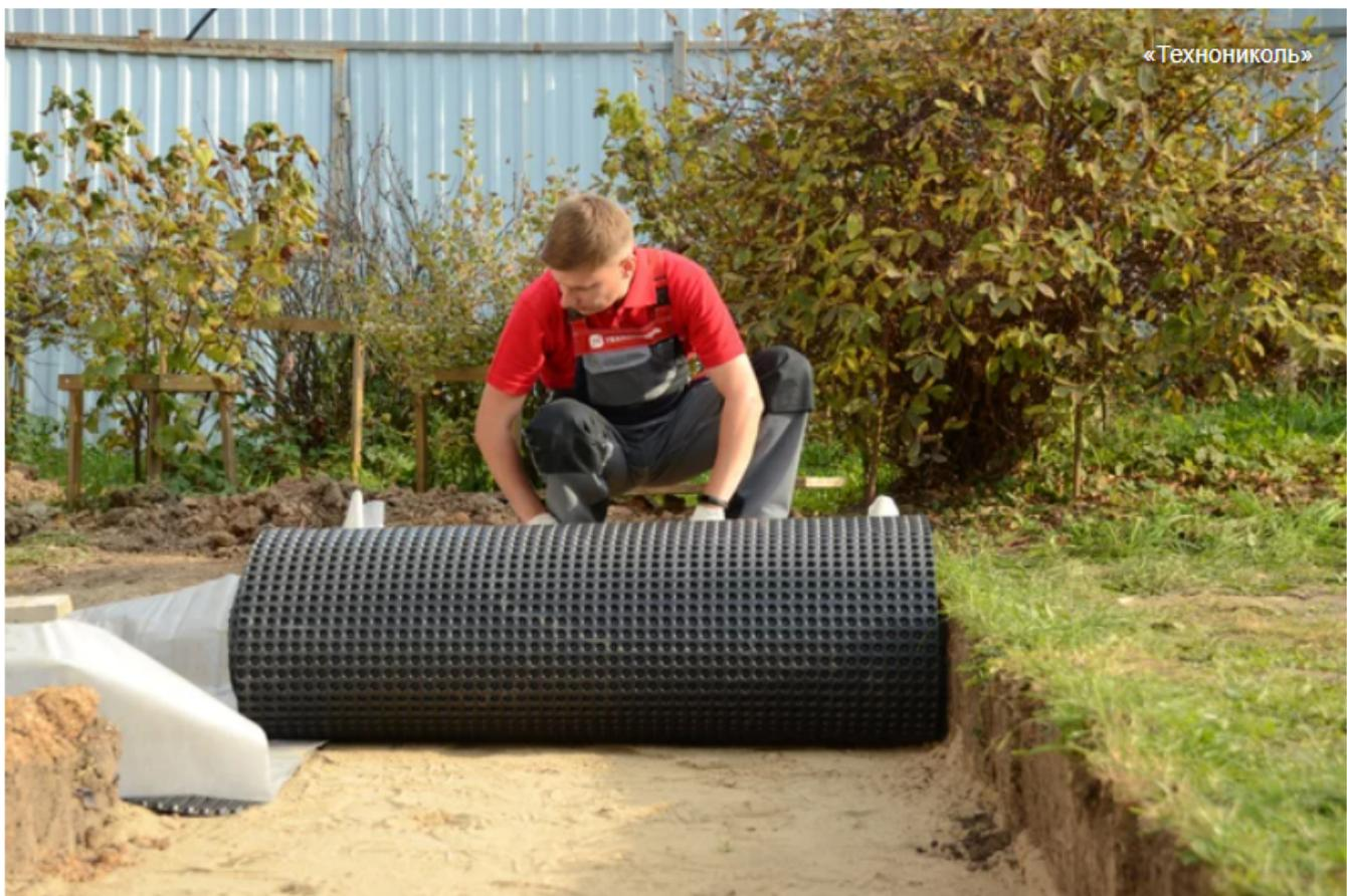
Хороший вариант — использовать в качестве дополнительного подстилающего дренажного
