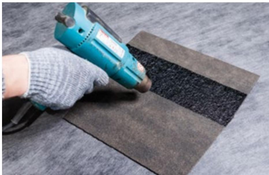
Самоклеящуюся полосу на плитке необходимо дополнительно подогревать строительным (тепловым) феном при температуре окружающей среды ниже + 5 °C.
