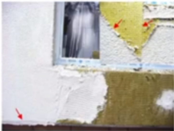
Армирование декоративной штукатуркой
