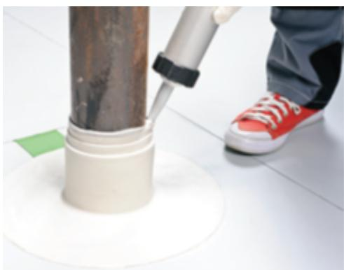
Затяните место примыкания металлическим хомутом. Обработайте швы жидким ПВХ ТЕХНОНИКОЛЬ.
