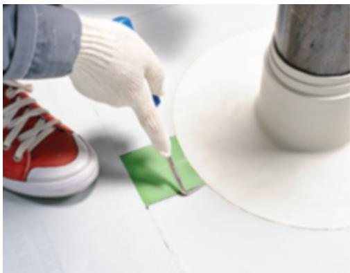
Заполните примыкание готового элемента к трубе полиуретановым герметиком ТЕХНОНИКОЛЬ.
