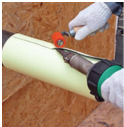
Разогревайте феном небольшой участок нижней части заготовки, пока мембрана в этом месте не станет пластичной.
