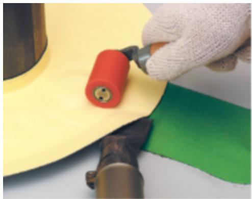
Вырежьте из неармированной мембранны **V-SR** полосу шириной **30-40 см**. Длина полосы должна быть больше длины окружности трубы на **4 см**, чтобы обеспечить нахлест для получения сварочного шва.
