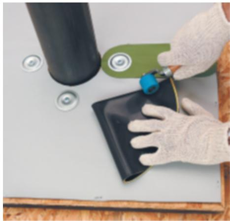
Нагревайте заготовку с обеих сторон вокруг отверстия с помощью фена до тех пор, пока мембрана не станет пластичной.
