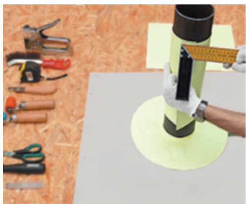
Оберните заготовку вокруг трубы, притяните ее пальцами и прихватите в нескольких местах внутри нахлеста с помощью ручного фена. Используйте узкую насадку шириной 20 мм.
