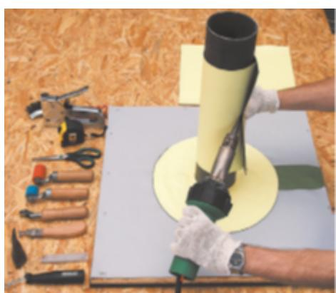
Снимите заготовку с трубы и закруглите ножницами нижний угол мембранны в нахлесте.
