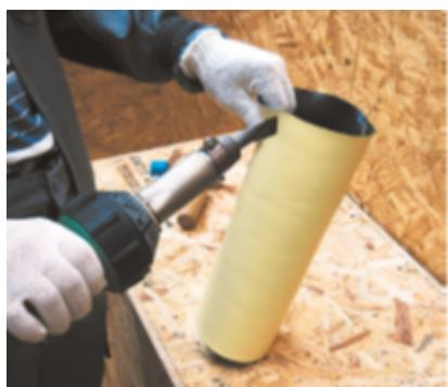
Разогревайте феном небольшой участок нижней части заготовки, пока мембрана в этом месте не станет пластичной.
