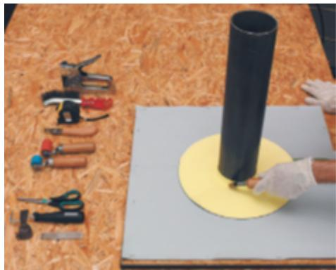
Приварите место перехода с вертикали на горизонталь с помощью фена, прикатывая латунным роликом. Снимите фаску с края заплатки на ширину сварного шва (не менее **30 мм**).
