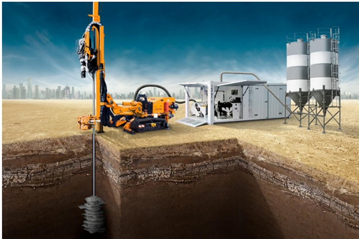
В связи с существованием разных типов грунтовых оснований проектированию и строительству зданий и сооружений предшествуют инженерно-геологические и гидрогеологические изыскания. Они заключаются в определении типов грунтов оснований, их прочности и деформативных характеристик, уровня грунтовых вод, их химического состава для установления степени агрессивности по отношению к материалу фундаментов.
