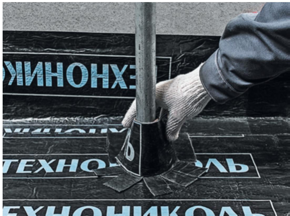
Подготовьте дополнительные заплатки из материала для герметизации заготовки на горизонтальной поверхности:
