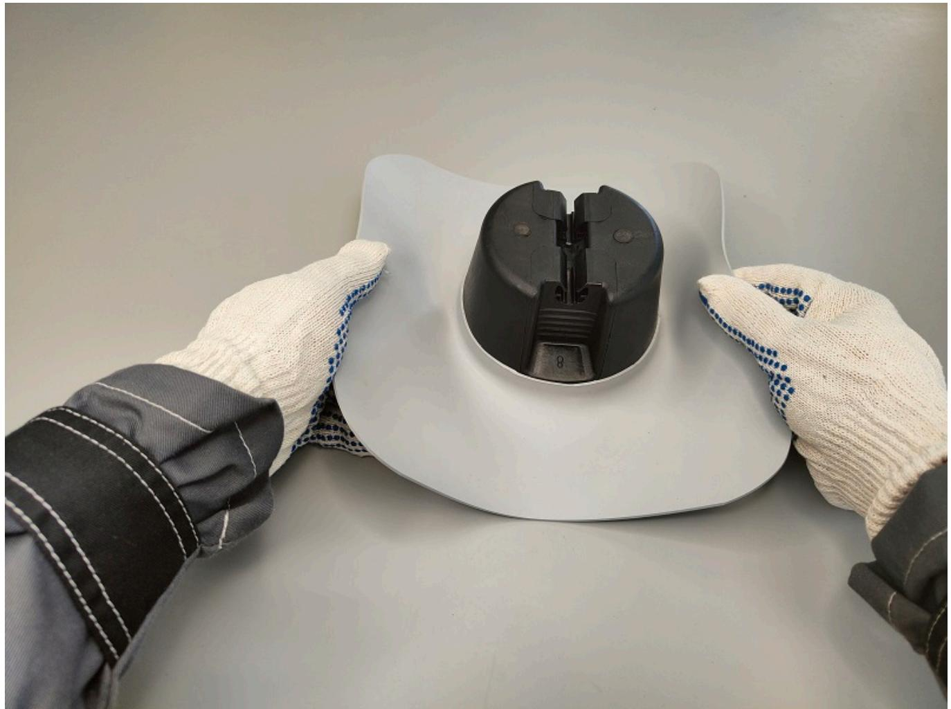
При помощи горячего воздуха, привариаем получившийся фартук к гидроизоляционному слою нашей кровли.
