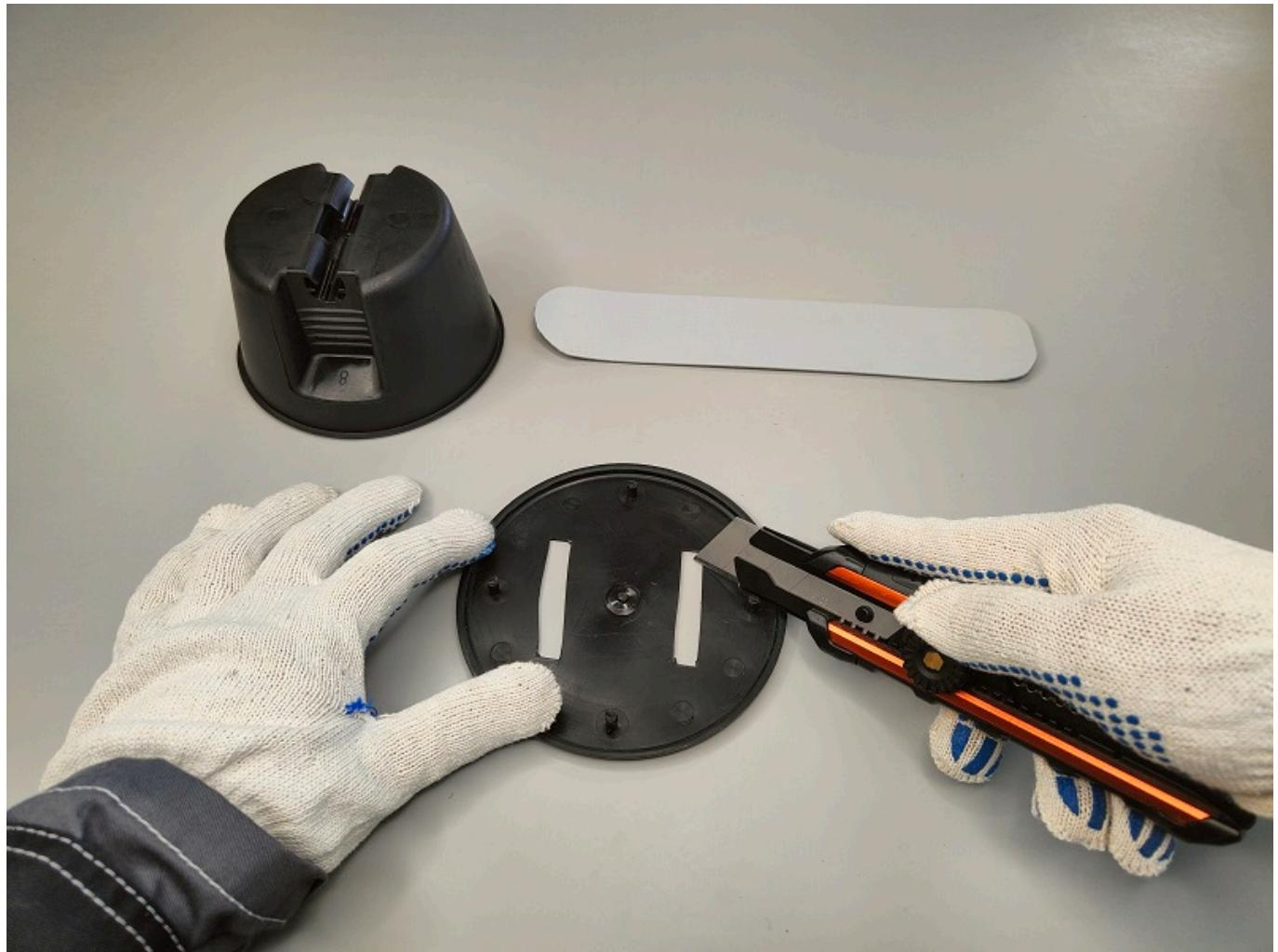
Продеваем полоску из ПВХ мембранны в вырезанные отверстия и привариаем её к гидроизоляционному слою нашей кровли.
