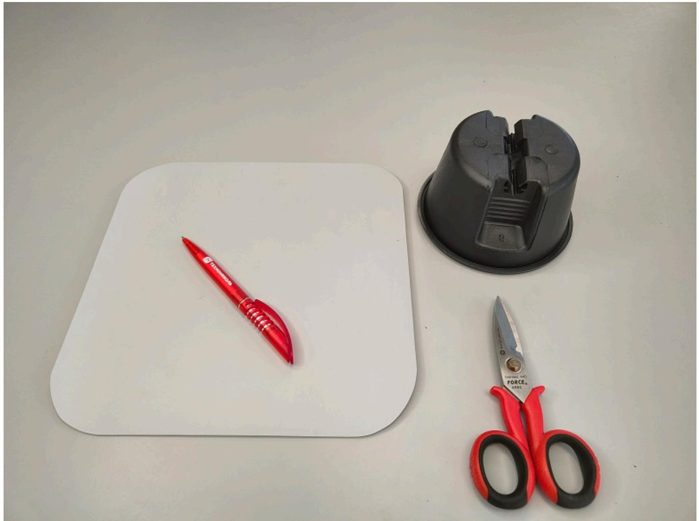
В центре нермированной ПВХ мембранны размером 25 на 25 см, при помощи ручки обводим верхнюю часть держателя провода-молниеотвода.
