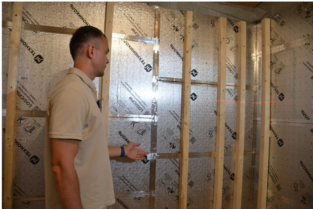
На фото: Проклеенныестыки термоплит *LOGICPIR* и смонтированные деревянные рейки под финишную отделку
