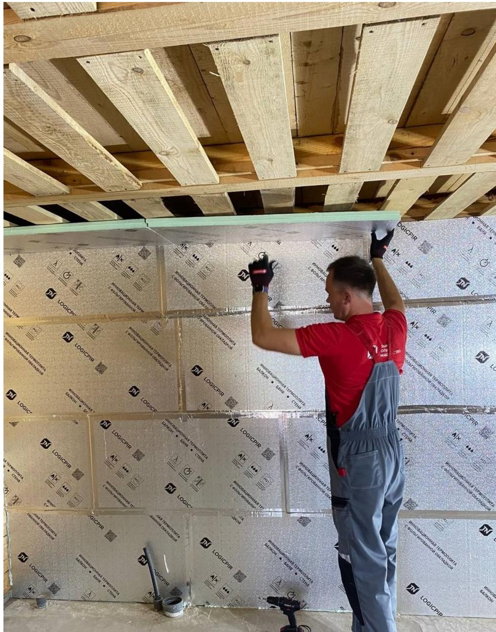
Образовавшийся между фольгированным утеплителем и внутренней отделкой зазор не менее 20 мм позволяет максимально использовать преимущества LOGICPIR как отражательной теплоизоляции. Фольга не только не пропускает пар и влагу, но и, подобно зеркалу, выступает теплоотражателем, возвращая в помещение до 95 % энергии инфракрасных лучей от банной печи.
