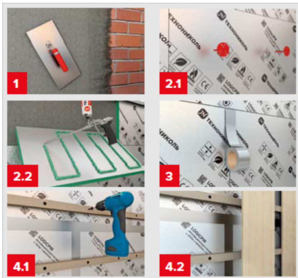
Рисунок 4. Этапы монтажа ТН-СТЕНА Термо PIR.
