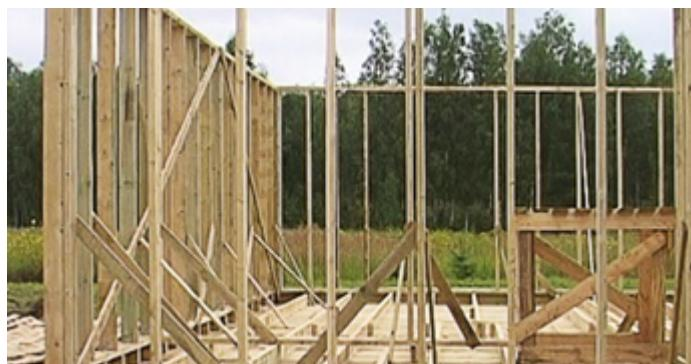
Деревянный каркас стен состоит из несущих стоек, обвязок и раскосов, изготовленных из деревянных брусьев, слоистых kleеных изделий или деревянных двутавровых балок. Не допускается использование древесины с влажностью более 19 %.
