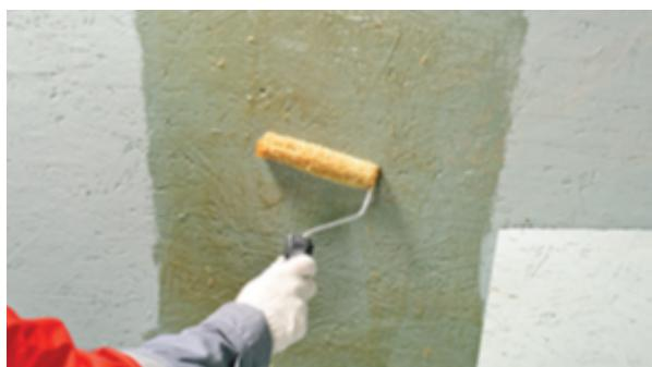
Затем нанесите клей на часть заготовки для угла. Следите, чтобы клей не попал в зоны будущего сварного шва.
