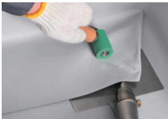
Приварите место примыкания полученного «конверта» к основному кровельному ковру с помощью узкого латунного ролика.
