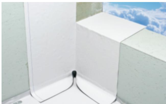
Загните нижние нахлести заготовки для угла. Под заготовку желательно настелить кусок мембранны, чтобы не испачкать kleem основной кровельный ковер.
