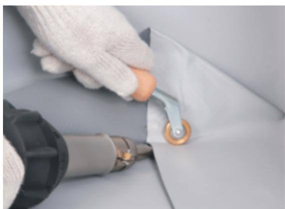
Приварите шов в месте перехода из «конверта» в нахлест мембранны при помощи латунного ролика.
