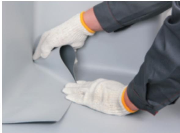
Для удобства работы прикатайте мембрану вдоль ребер угла латунным роликом и прихватите к основному кровельному ковру с помощью ручного фена.
