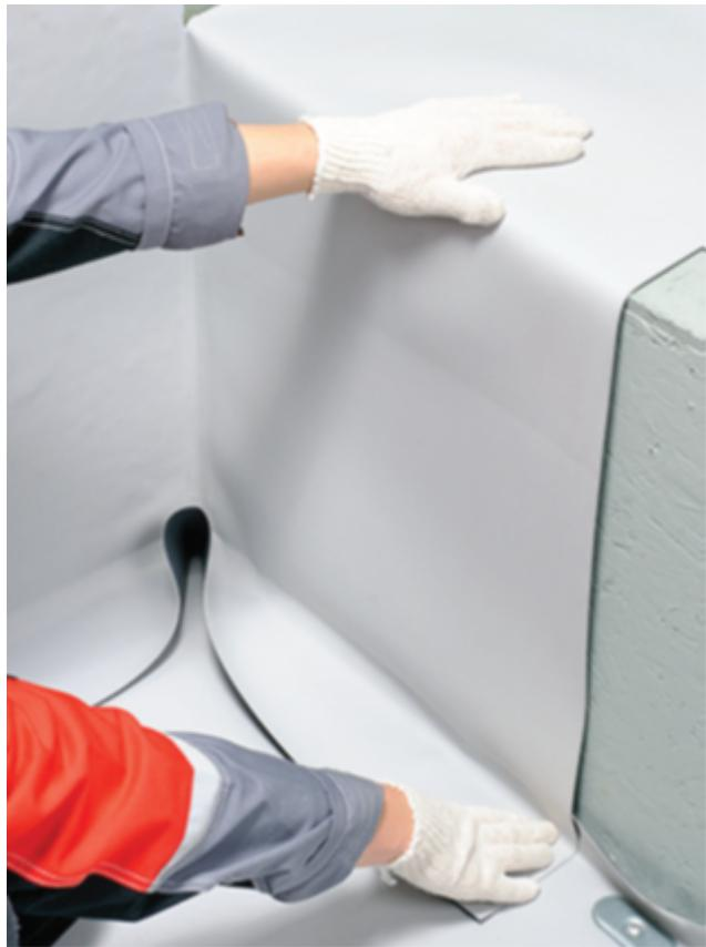
Нанесите клей на второй парапет и вторую часть заготовки.
