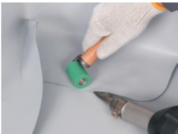
С помощью узкого латунного ролика приварите место перехода с нахлеста мембранны в «конверт».
