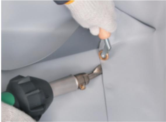
Далее приварите нахлест мембранны к основному кровельному ковру обычным образом с помощью силиконового ролика.
