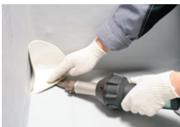
Доварите края элемента узким латунным роликом.
