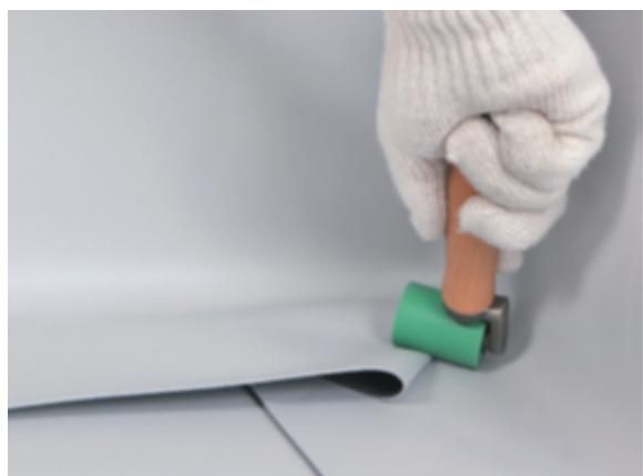
Для избежания повреждения нижних слоев материала подложите под петлю из мембранны металлическую пластину с обработанными краями толщиной 0,3-0,5 мм из оцинковки или нержавейки и сделайте прихватку.
