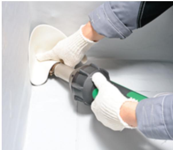
Проварите радиусы элемента с помощью латунного ролика.
