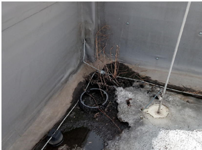
9. Ошибки сопряжения кровельных материалов с узлами прохода коммуникаций, местами установки оборудования.
