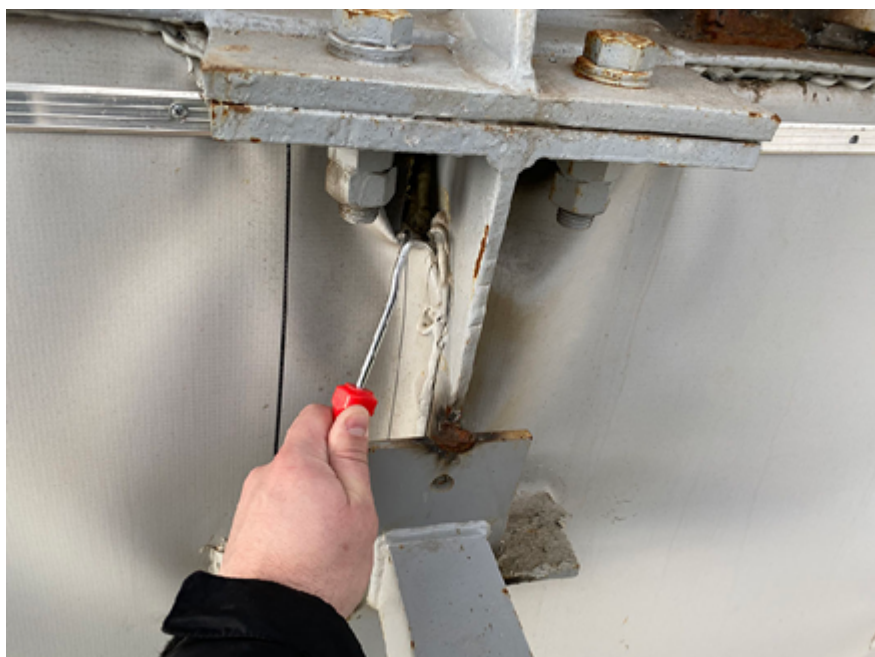
9. Ошибки сопряжения кровельных материалов с узлами прохода коммуникаций, местами установки оборудования.
